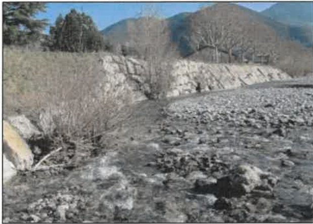
Figure 4 : Enrochements libres sur sabot (toute la hauteur du parement, réalisés en 2010)
