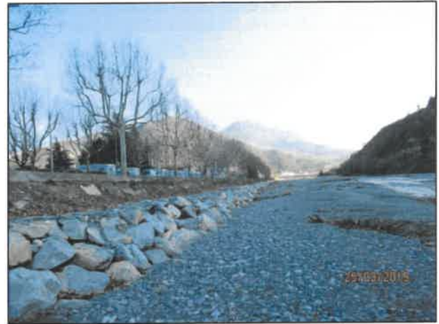
Figure 7 : Enrochements libres sur sabot (2017)
