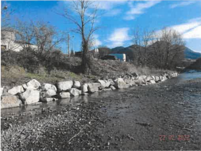
Figure 2 : Limite amont (enrochements libres sur sabot, réalisés en 2013)
