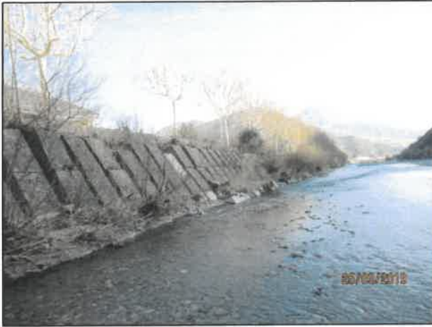
Figure 6 : Dominos anciens devant perré béton
