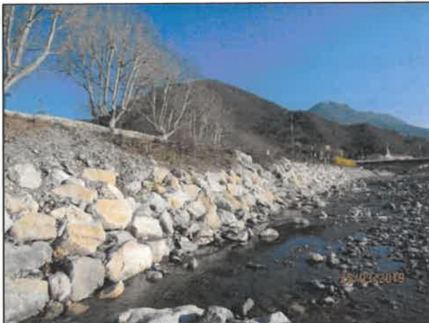
Figure 8 : Enrochements libres sur sabot (2017)
