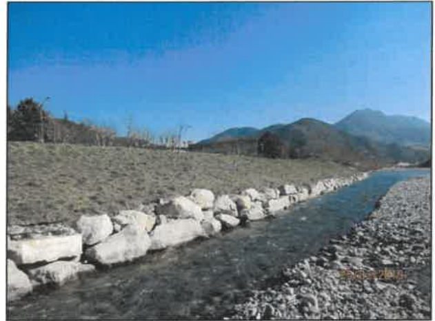
Figure 3 : Enrochements libres sur sabot et géogrillage (réalisés en 2013)
